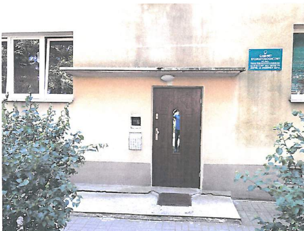
Zdjęcie nr 4 – fragment elewacji północno – zachodniej, wejście do budynku
