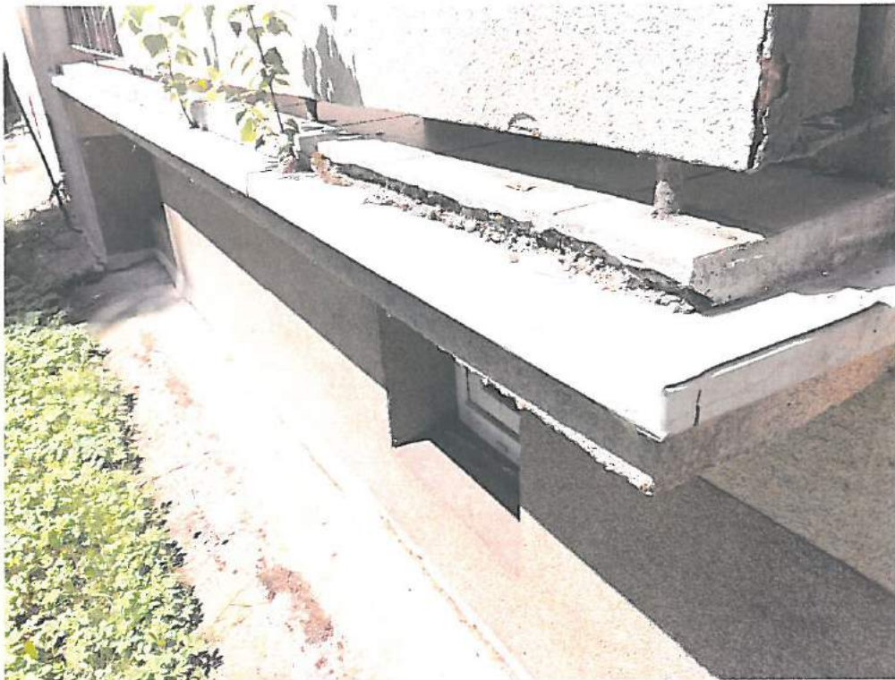
Zdjęcie nr 12 – Fragment elewacji północno – wschodniej, balkon w poziomie parteru
