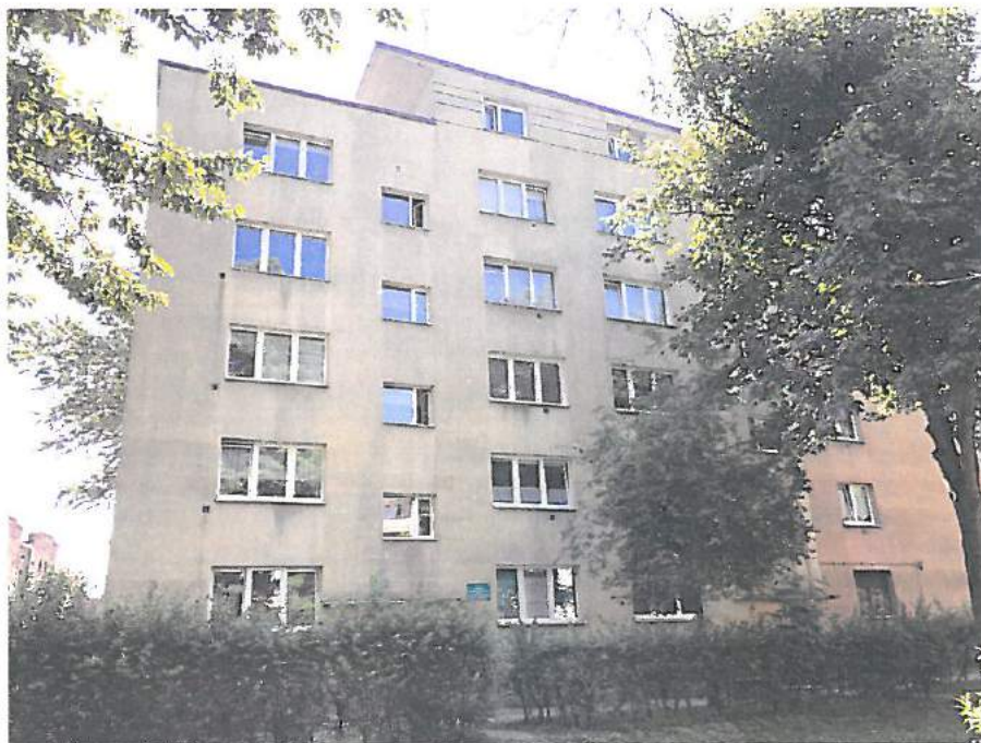
Zdjęcie nr 1 – Elewacja północno - zachodnia
