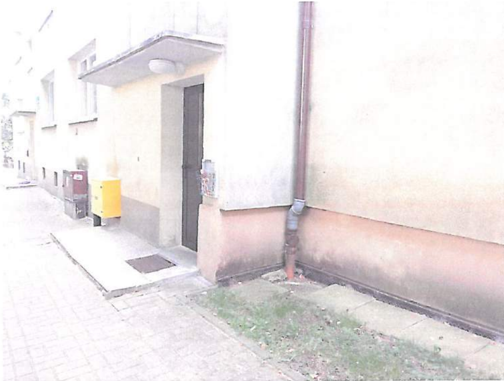
Zdjęcie nr 5 – fragment elewacji północno – zachodniej, wejście do budynku
