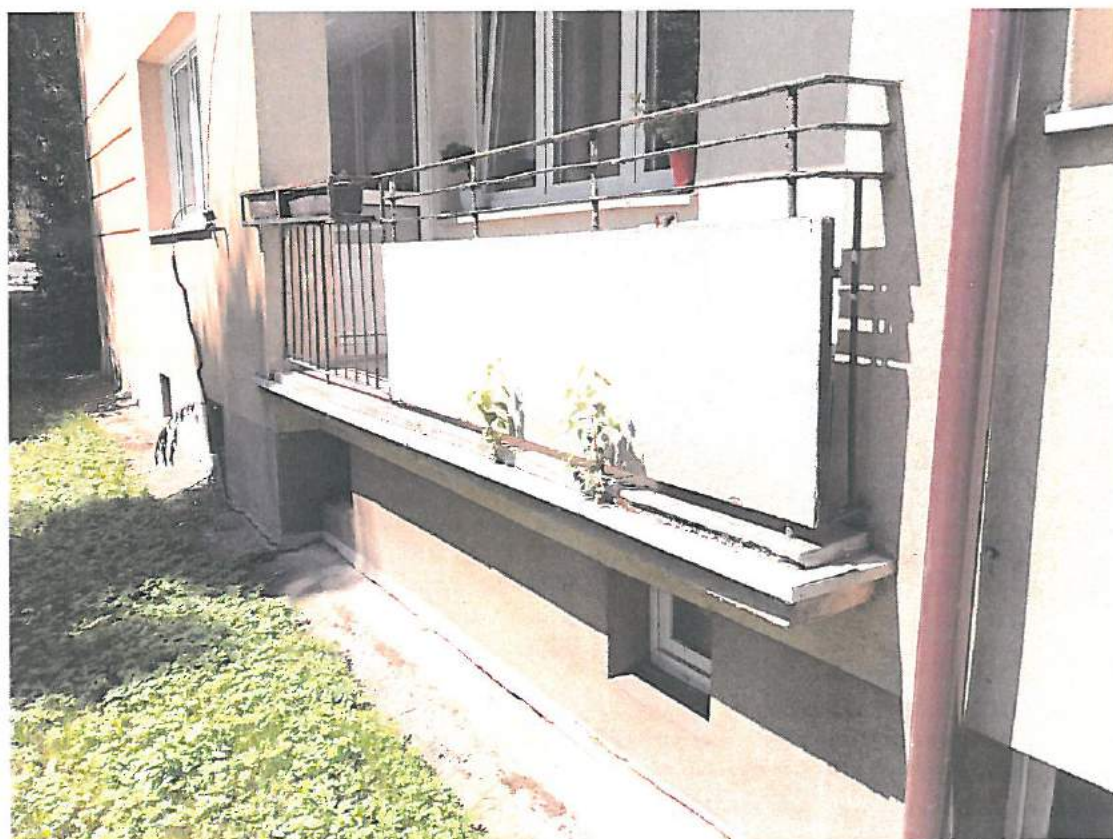
Zdjęcie nr 11 – Fragment elewacji północno – wschodniej, balkon w poziomie parteru
