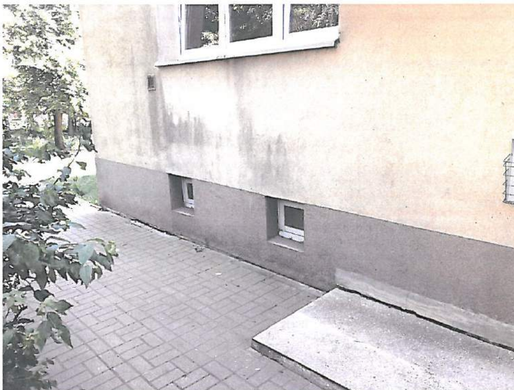
Zdjęcie nr 3 – fragment elewacji północno – zachodniej, strefa cokołowa,
