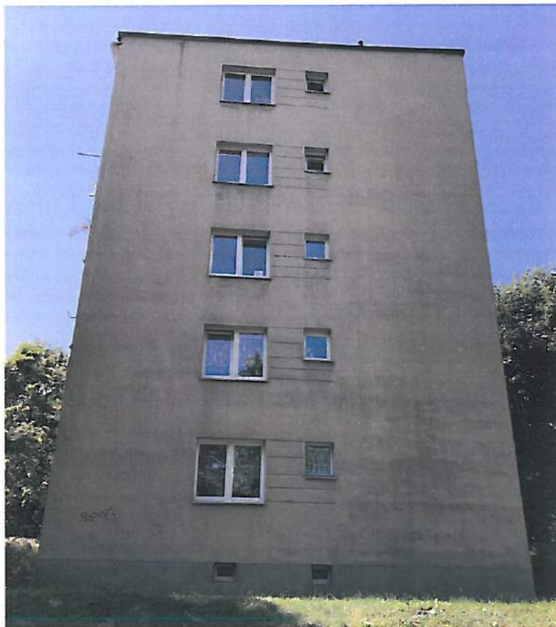
Zdjęcie nr 11 – Elewacja północno – wschodnia
