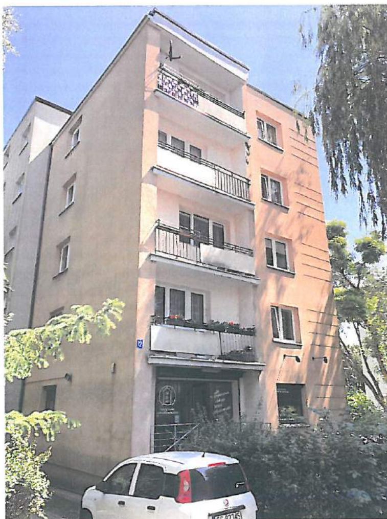
Zdjęcie nr 7 – Elewacja południowo – zachodnia
