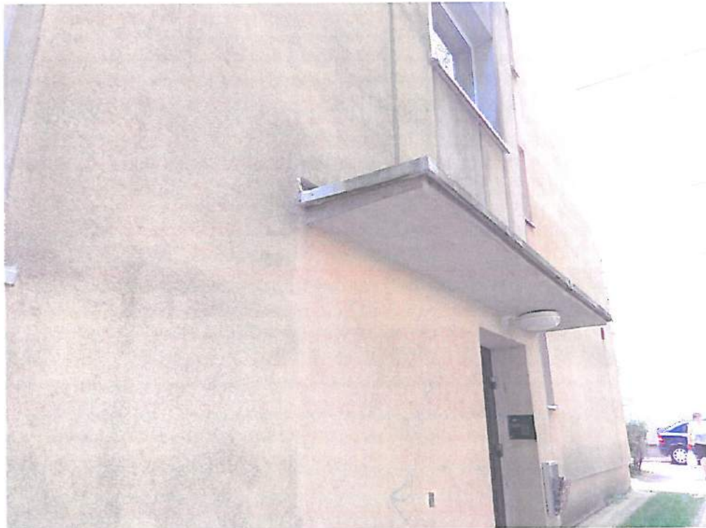
Zdjęcie nr 6 – fragment elewacji północno – zachodniej, zadaszenie nad wejściem do budynku
