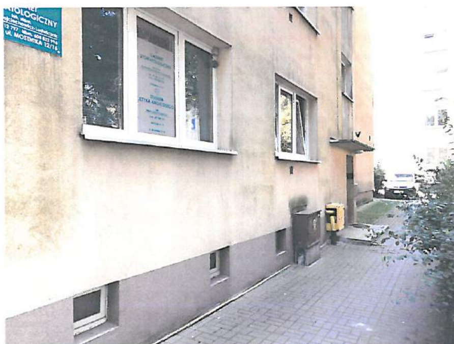
Zdjęcie nr 2 – fragment elewacji północno – zachodniej, strefa cokołowa, widoczna skrzynka gazowa i elektryczna
