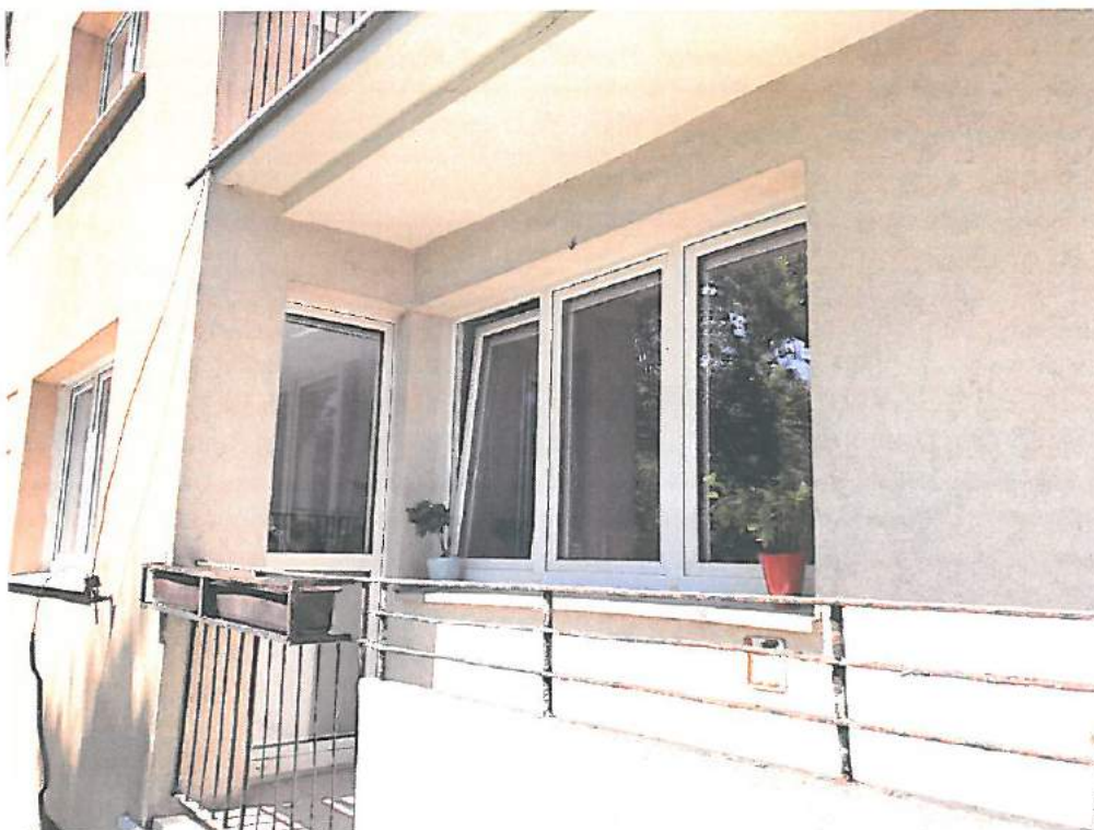
Zdjęcie nr 13 – Fragment elewacji północno – wschodniej, balkon w poziomie parteru, balustrada balkonowa
