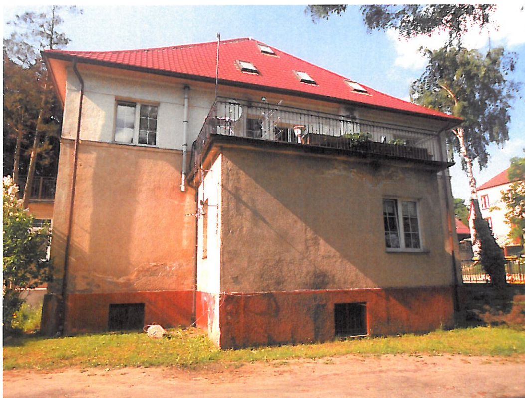
ELEWACJA OD STRONY PRZEJAZDU
