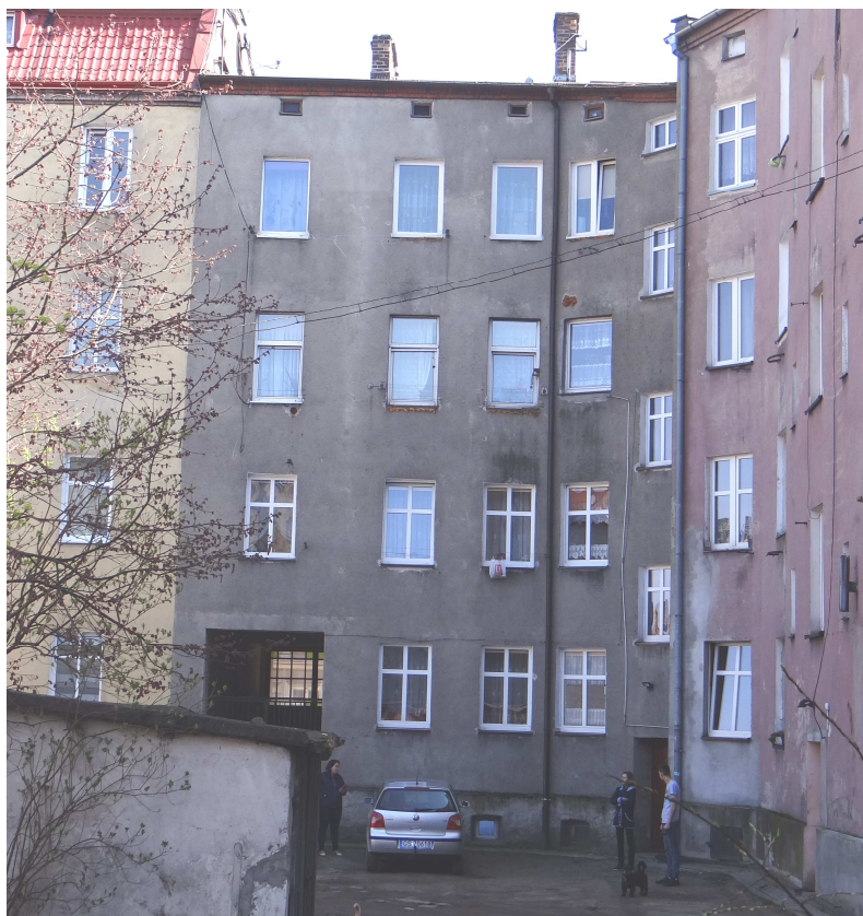
Zdjęcie nr 4 - Elewacja zachodnia
