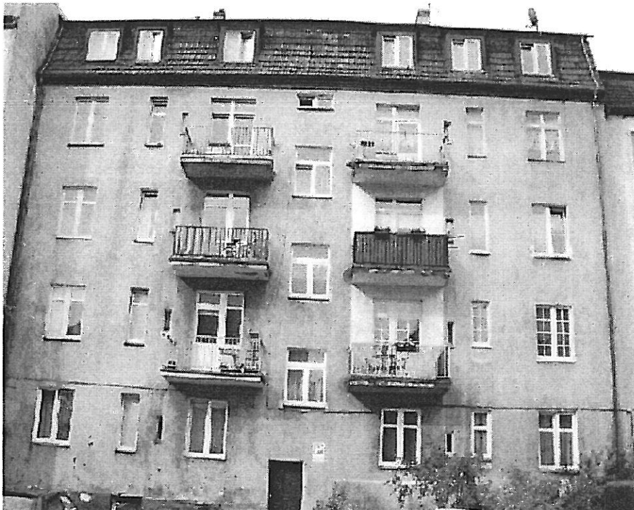
ELEWACJA TYLNA BUDYNKU
